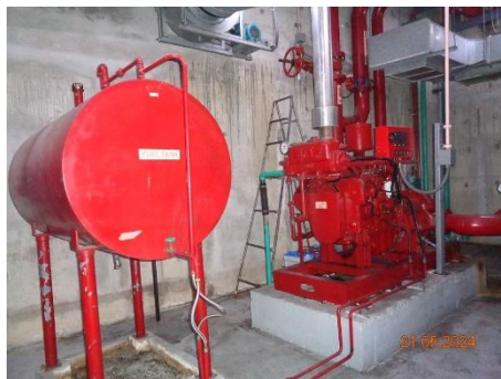
ภาพที่ 2.2-34 เครื่องสูบน้ำดับเพลิง (Fire Pump)
