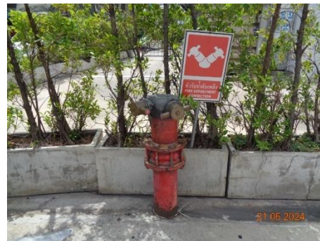
ภาพที่ 2.2-33 หัวรับน้ำดับเพลิง (Fire Department Connector : FDC)
