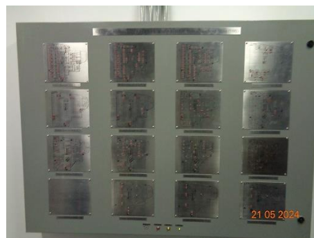
ภาพที่ 2.2-38 แผงควบคุม (Fire Alarm Control Panel : FCP)
