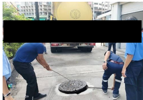
ภาพที่ 2.2-14 การสูบกากตะกอน จากระบบบำบัดน้ำเสีย
