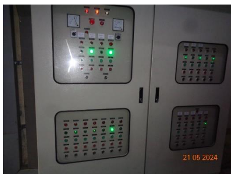
ภาพที่ 2.2-15 การติดตั้งมิเตอร์ไฟฟ้าสำหรับ ระบบบำบัดน้ำเสีย
