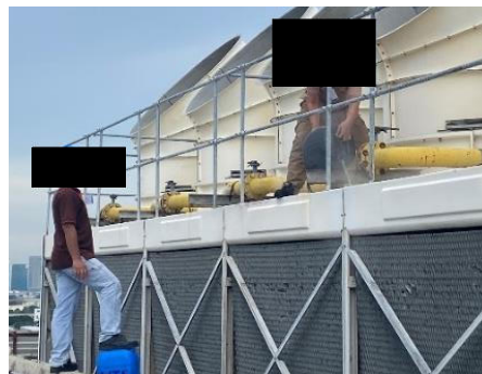
ภาพที่ 2.2-44 การเติมสารชีวฆาตในท่อฝังเย็น
