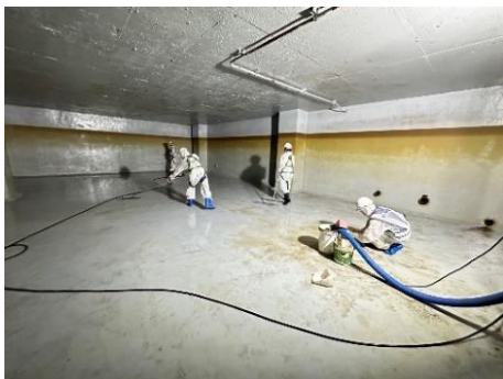
ภาพที่ 2.2-20 การทำความสะอาดถังเก็บน้ำ
